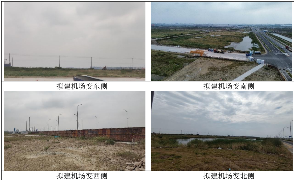
图 2-1 拟建变电站四周现场照片
